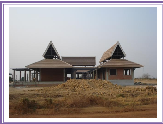
ภาพที่ 2 อาคารสำนักงาน
